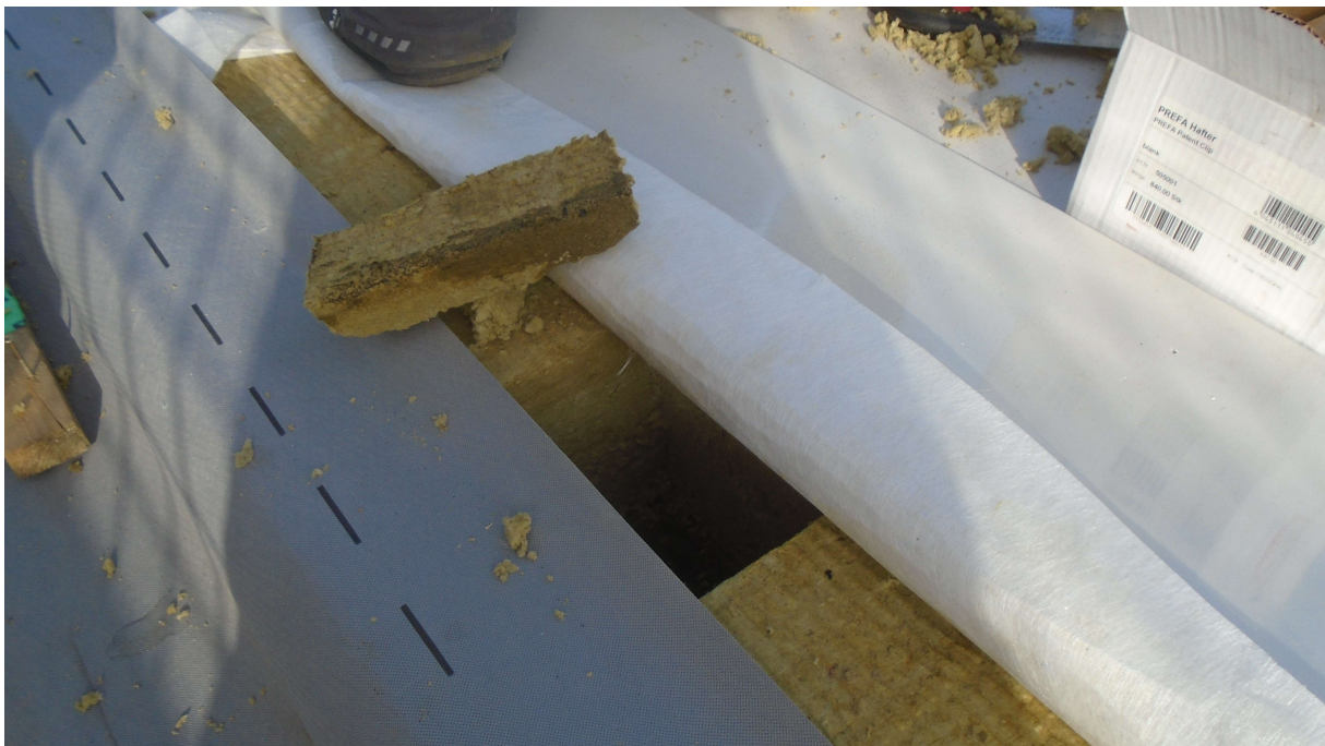
Im georteten Bereich des Flachdaches, mit der hohen Feuchtigkeit. Hier wurde ein Stück Dämmung herausgeschnitten. Dieses Stück war sehr nass. Bild 23.2.2021
