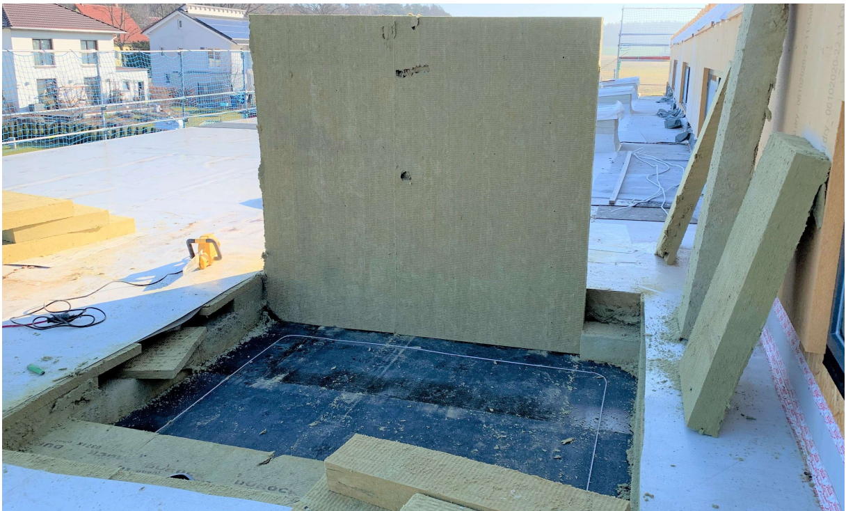
Die dunklen Stellen auf Bitumenbahnen sind noch feucht. Bild 2.3.2021
