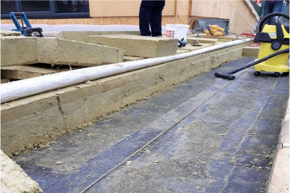
In diesen Bereich wurde das Wasser abgesaugt und die Dämmung ausgetauscht. 2.3.2021
